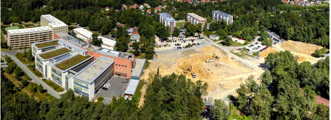
Abbildung: Waldklinik "Rudolf Elle" mit Baugrube für den Neubau
